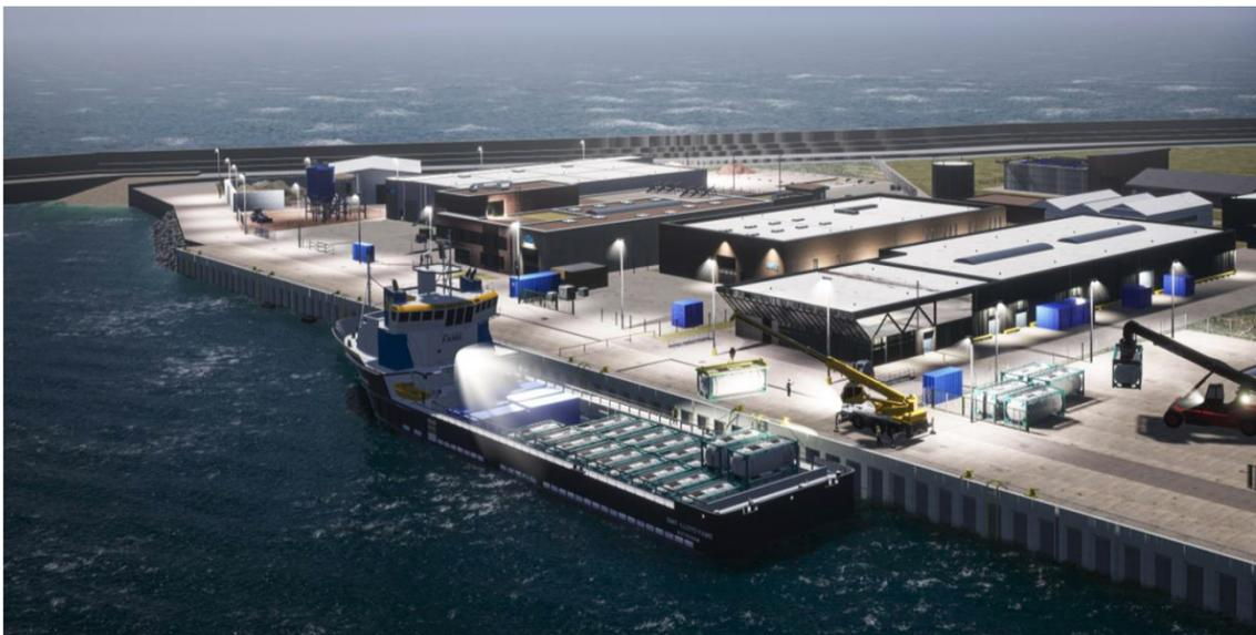
Abbildung 7. Exemplarische Visualisierung der Logistik per Containerschiff im Vorhafen mit Hafemobilkran und Reach-Stacker, Bild: Jakob Martens.
