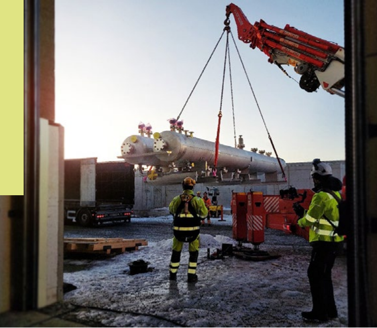
Installation eines 20-Megawatt-Elektrolyseurs für die Produktion von Wasserstoff und anderen Power-to-X-Produkten
