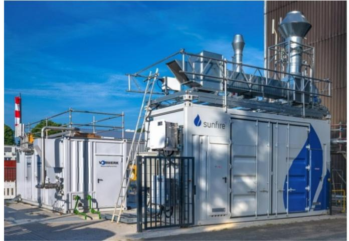
In Betrieb genommener 250 kW Hochtemperatur-Elektrolyseur.
